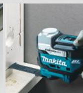
Trabalhos de abertura de portas
