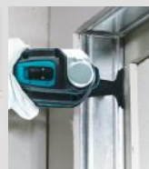
Remoção dos caixilhos das janelas
