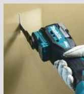
Corte de placas de gesso cartonado
