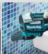
Colocação de juntas em revestimentos cerâmicos
