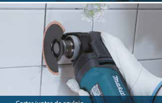
Cortar juntas de azulejo
